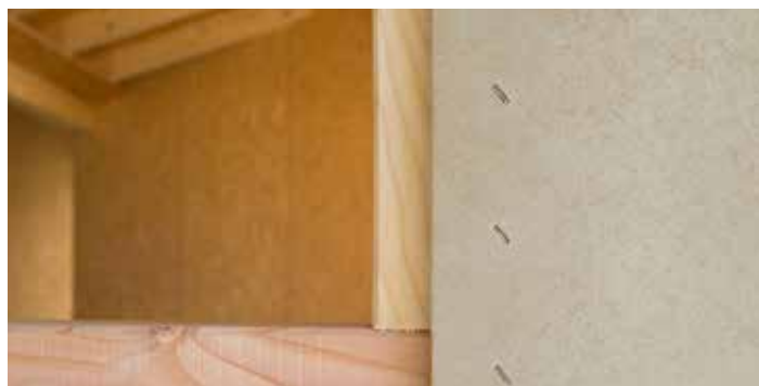
Duripanel monteret med klammer
