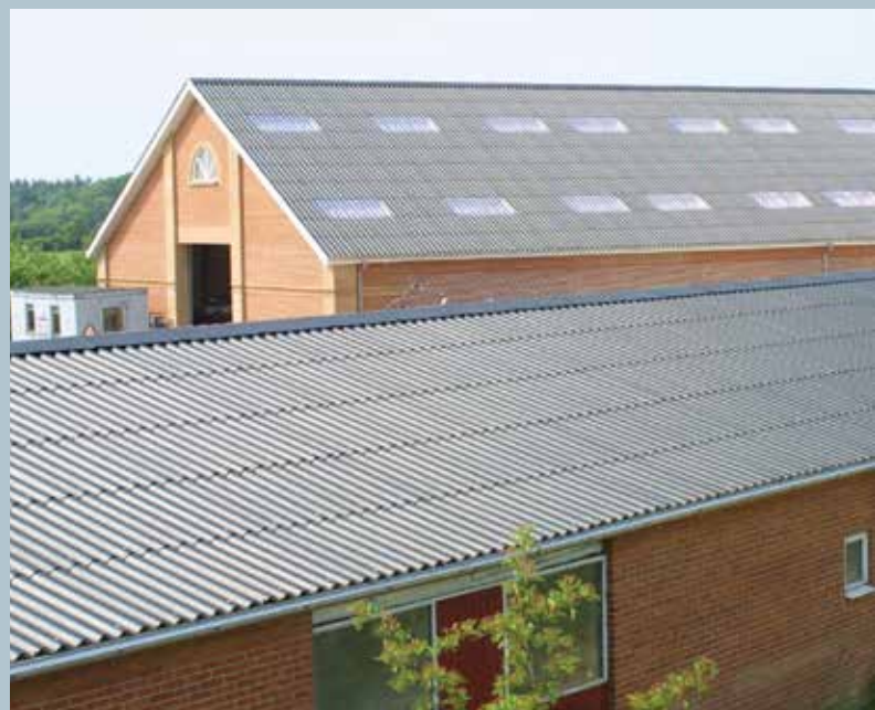
Naturlig daglys ned gjennom taket på maskinhuset med ivarcem lysplater.
