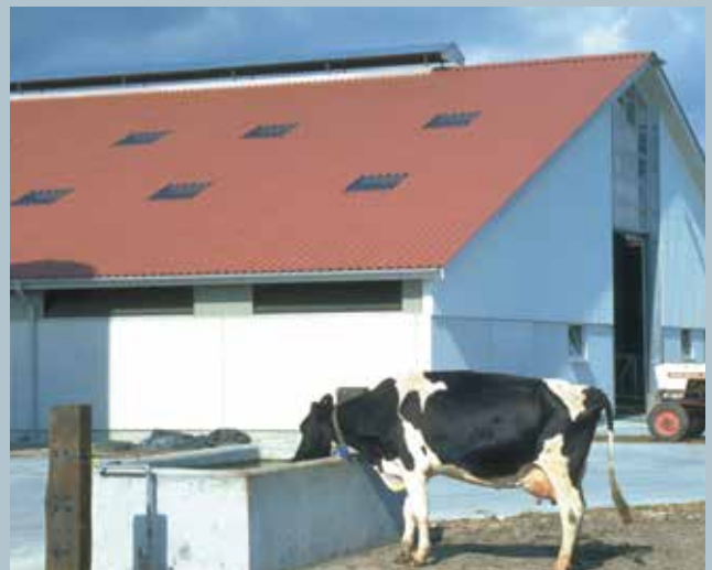
Naturlig daglys ned gjennom taket på maskinhuset med ivarcem lysplater.
