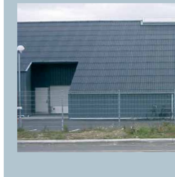
Utradisjonelt pyramidetak lagt med ivarcem-bølgeplater
