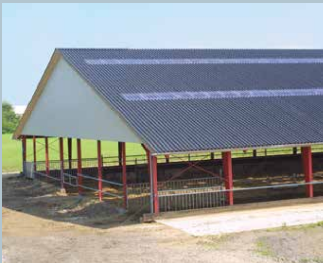
ivarcem bølgeplater som takdekke på et stort og åpent løsdriftsfjøs
