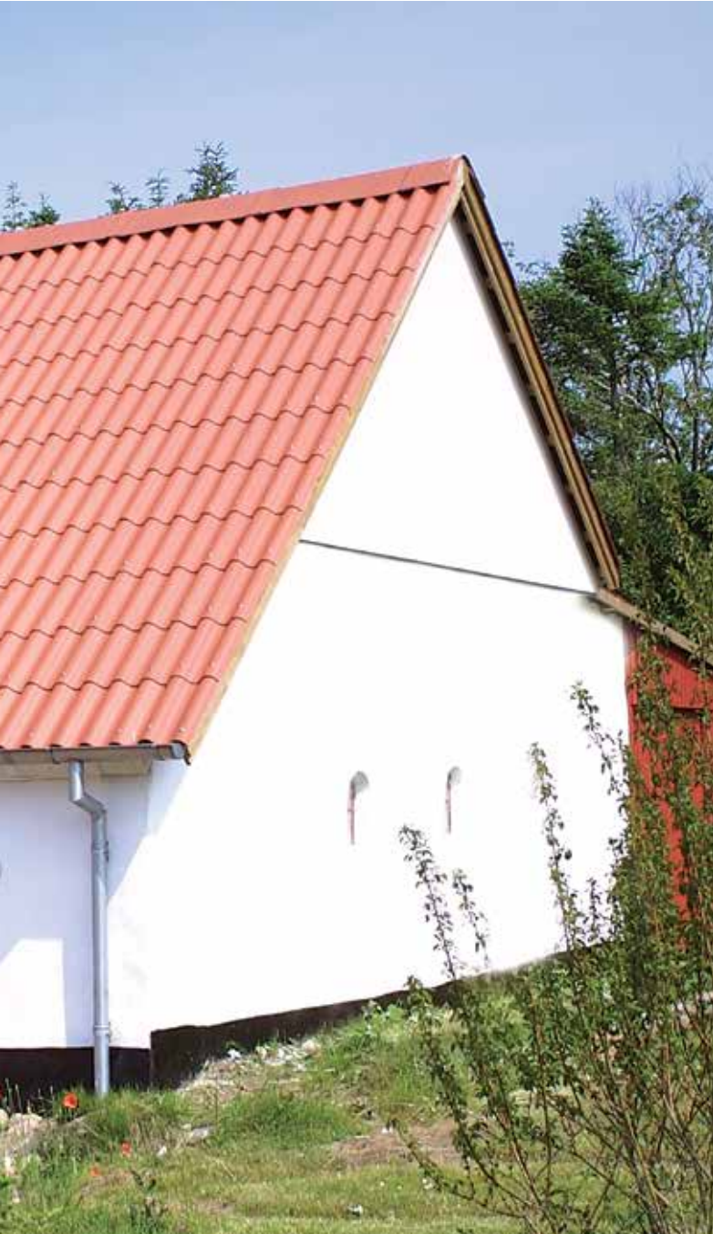
Taket skal skiftes.
