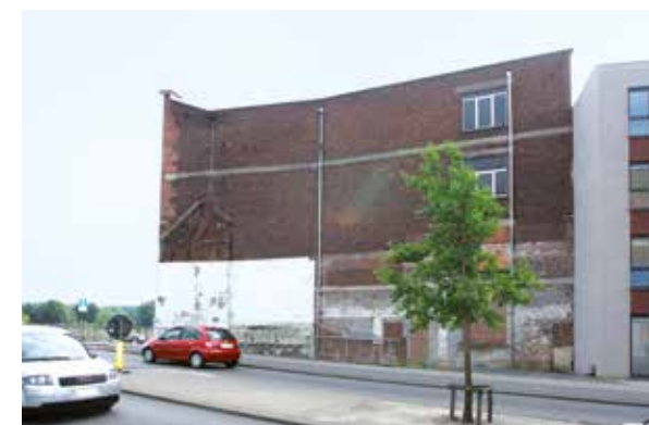
Lateral elevation prior to revitalisation Seitenfront vor der Revitalisierung Façade sur rue avant la revitalisation
