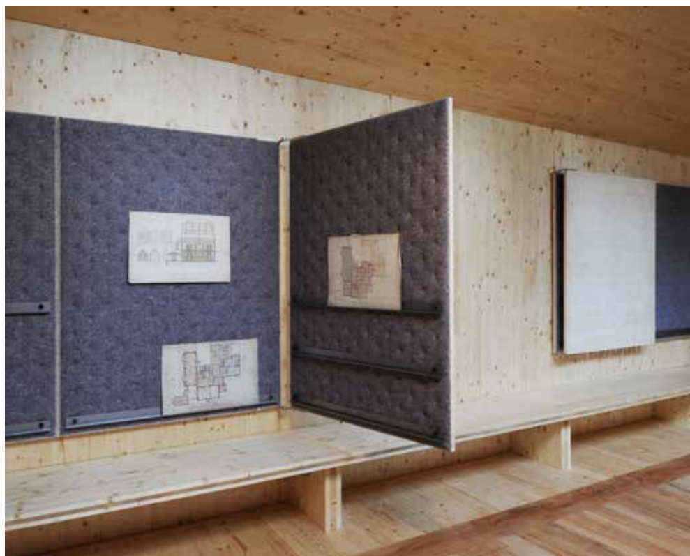
Folding panels to protect the exhibits from daylight. Klapptafeln als Lichtschutz der Exponate Panneaux rabattables pour protéger les pièces d'exposition
