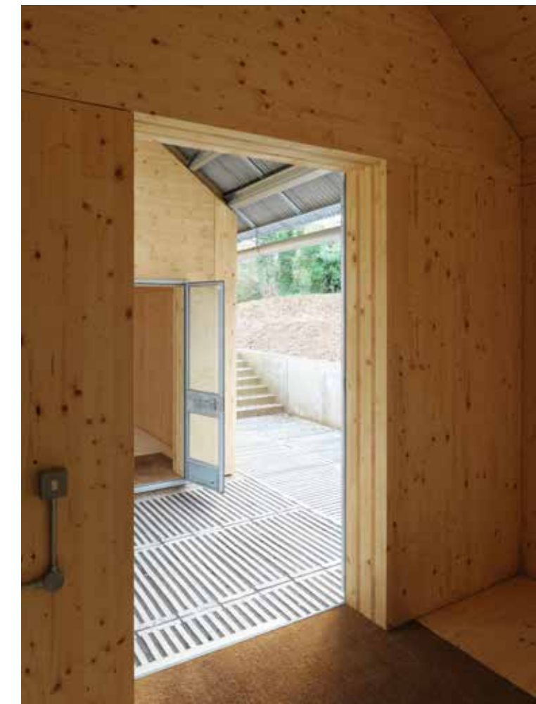
The underside of the fibre cement roofing panels, viewed from the open passageway. Im Durchgang ist unterseitig die Dachdeckung mit Faserzement-Welltafeln sichtbar. La sous-face en plaques ondulée de fibres-ciment de la couverture reste visible dans le passage.
