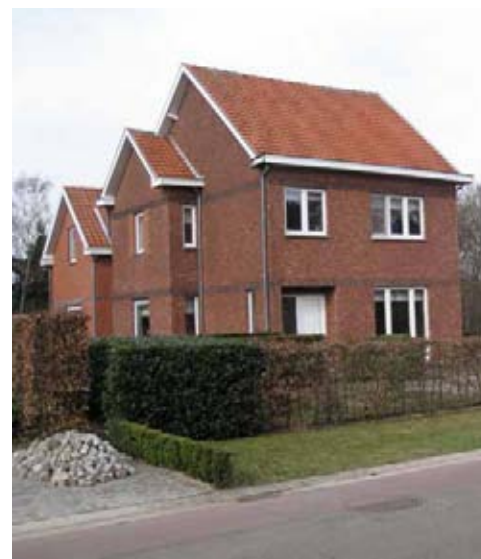
Prior to remodeling Vor der Sanierung Avant rénovation
