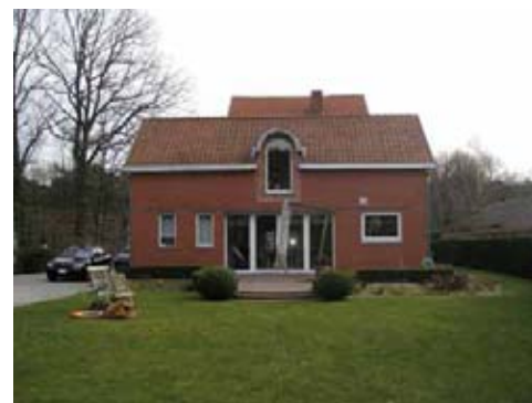
Prior to reconstruction Vor der Sanierung Avant rénovation
