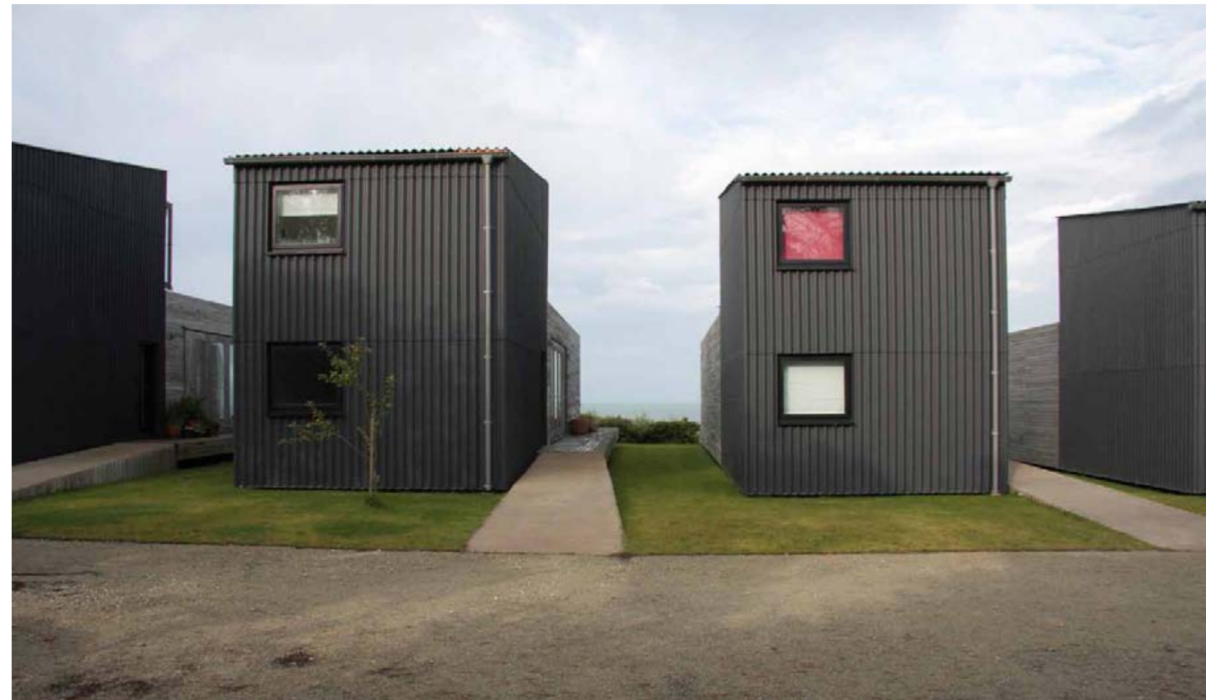
Des plaques ondulées en fibres-ciment et du bois (Red Cedar) caractérisent l'apparence des quatre maisons identiques.
